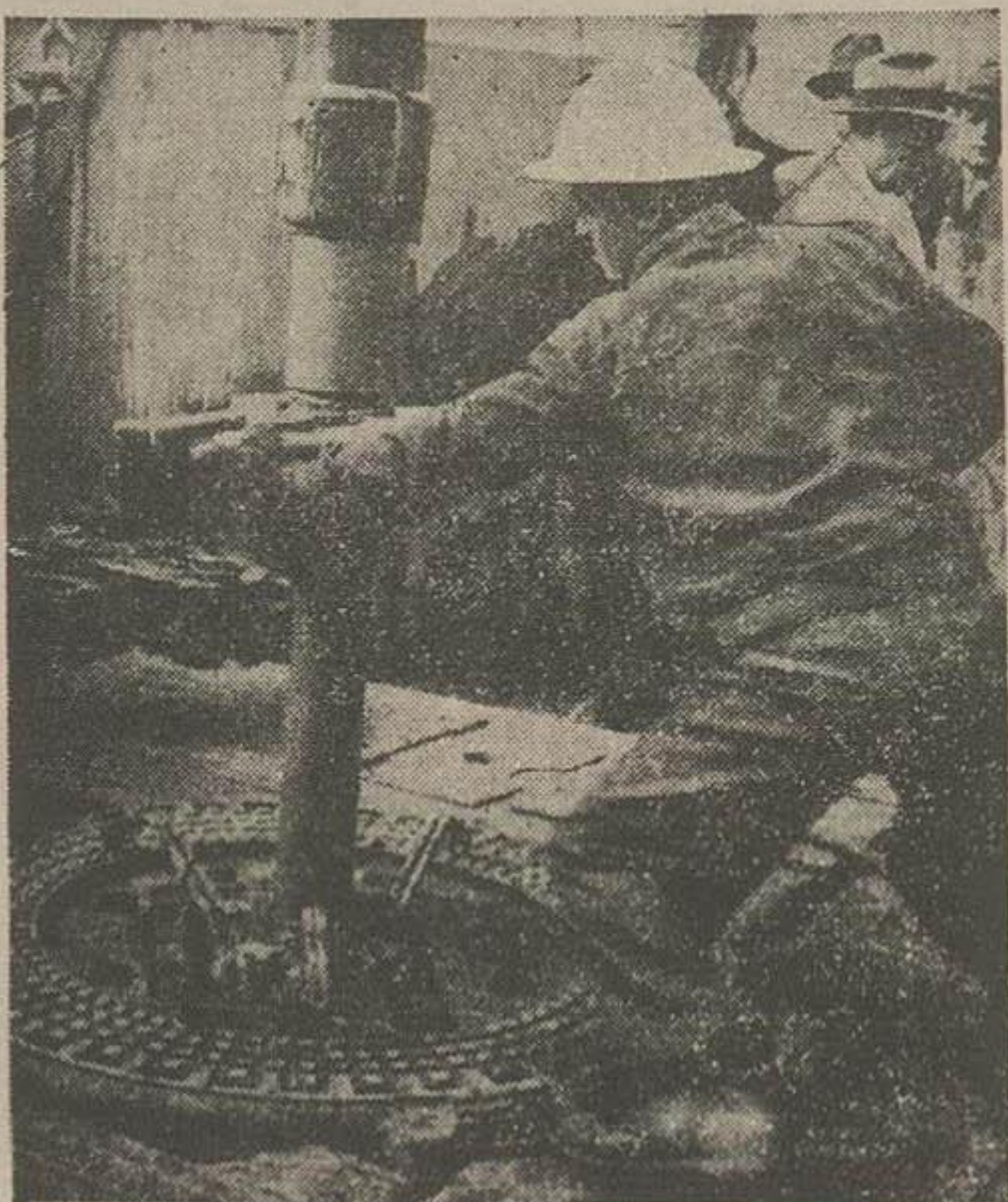
پس از چهارهفت ساعت تلاش دژ زیر گرمای طاقت فرسا، مجددا عملیات حفاری در منطقه چاه البرز آغاز گردید
