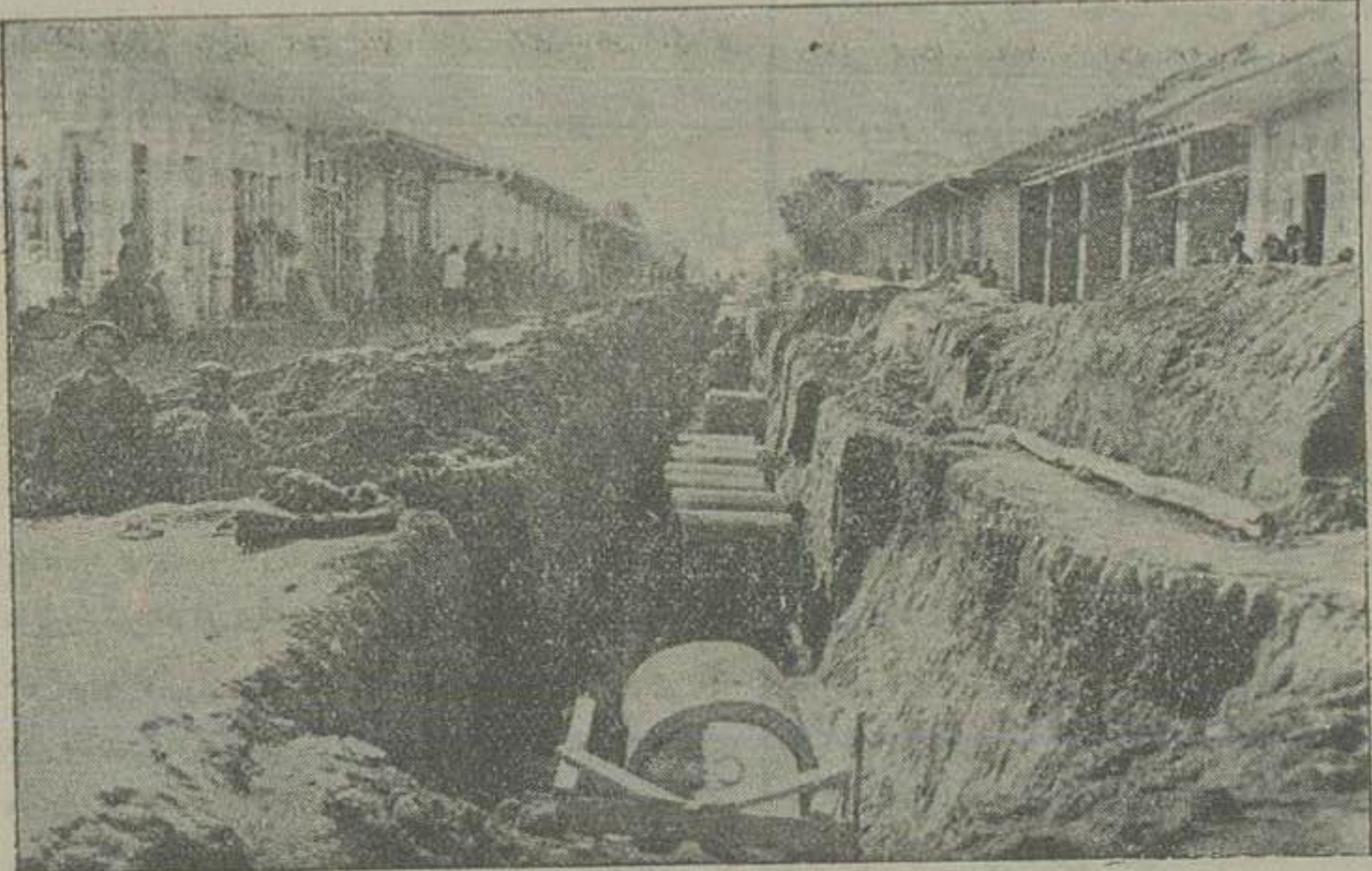
منظره از ساختمان مجاری زیر زمینی (اگو) در یکی از خیابان های شهسوار
