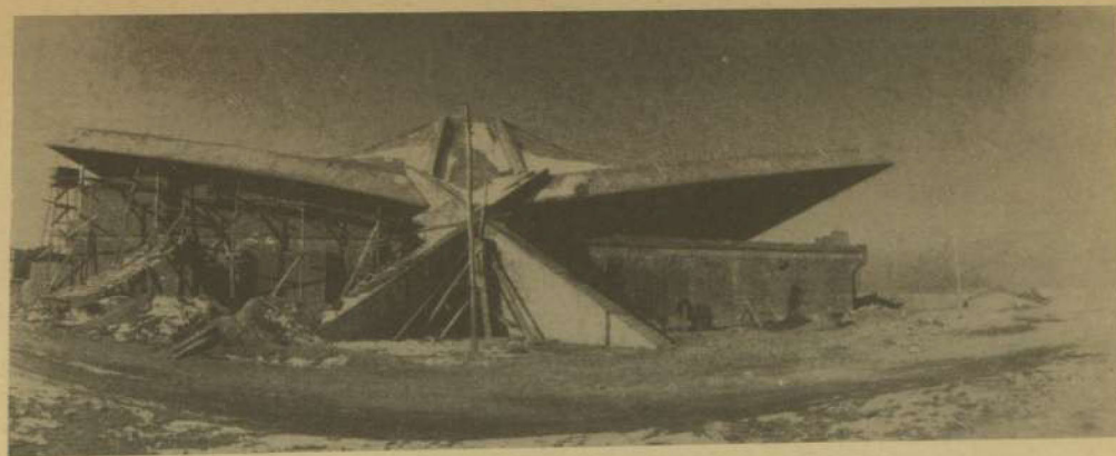
نمایی از مرکز تلویزیون تبریز هنگام ساختمان
