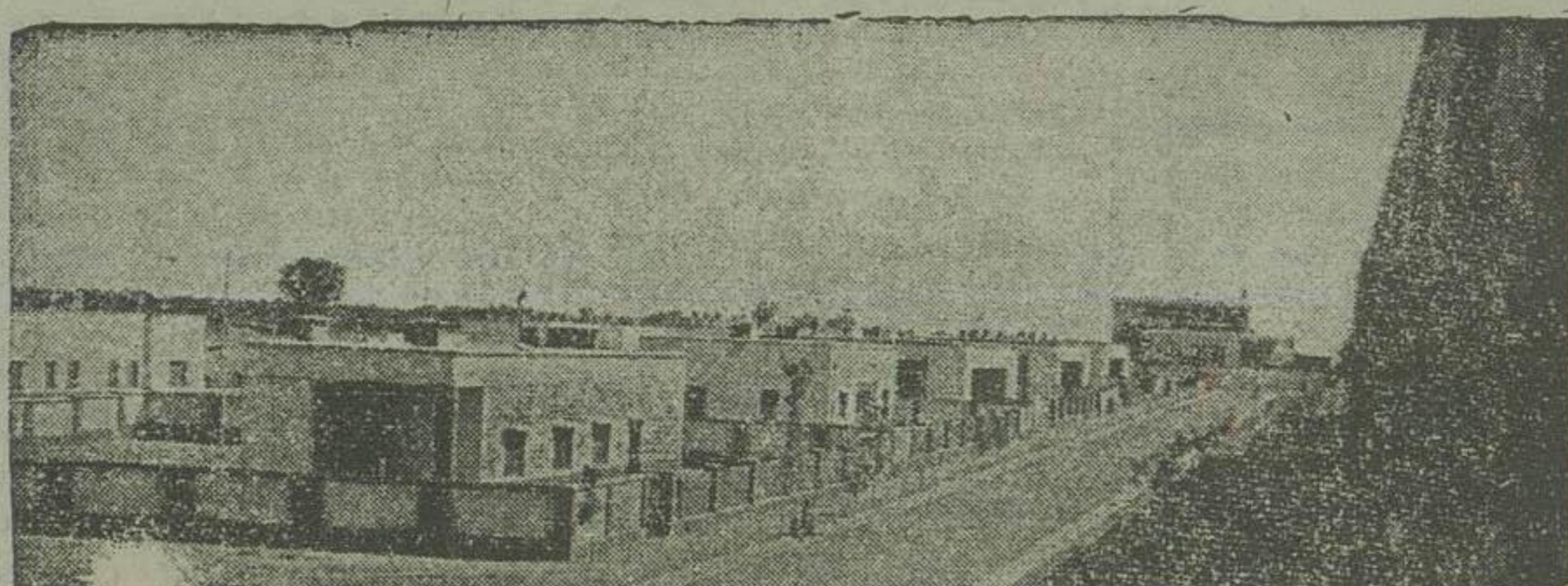
ساختمان های جدیدی که در ایستگاه قزوین بتازگی انجام شده است
