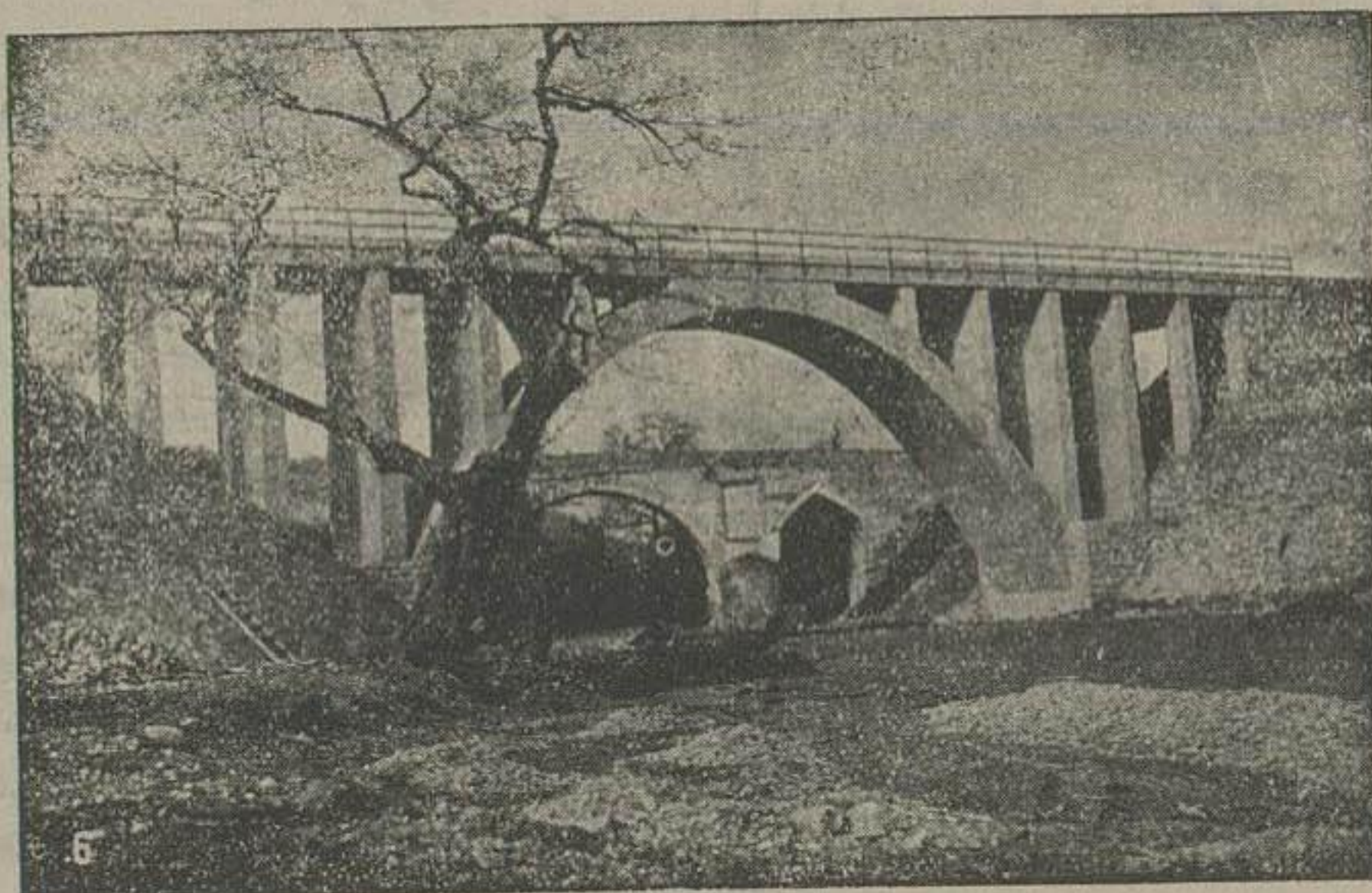
منظره پل ضربی خارخون در خط آهن شمال بین کیلومتر ۱۴۶ و ۱۴۷
