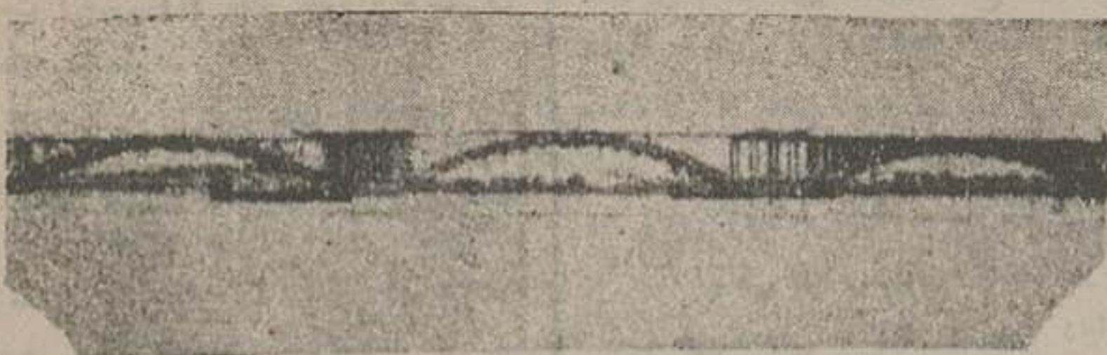
یک منظره از پل جدید غازیان
