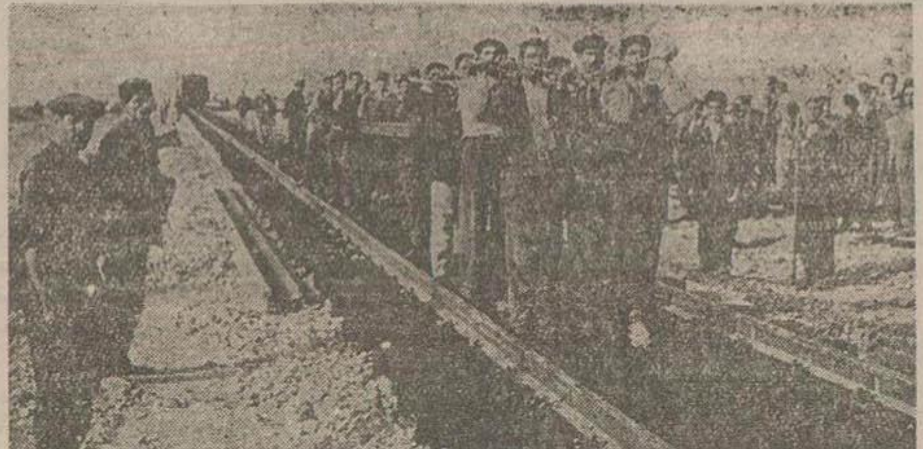
کارگران مشغول نصب ریلها میباشند
