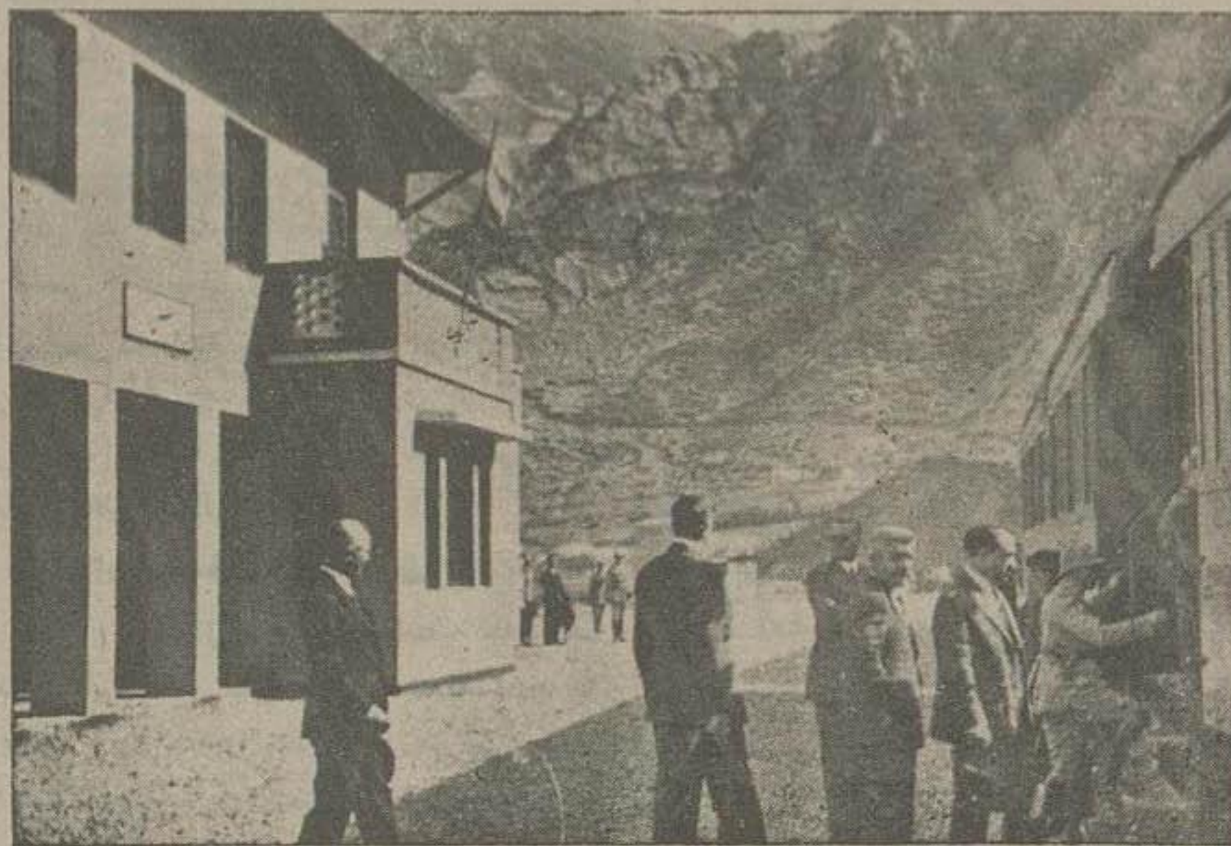
در ایستگاه عباس آباد
