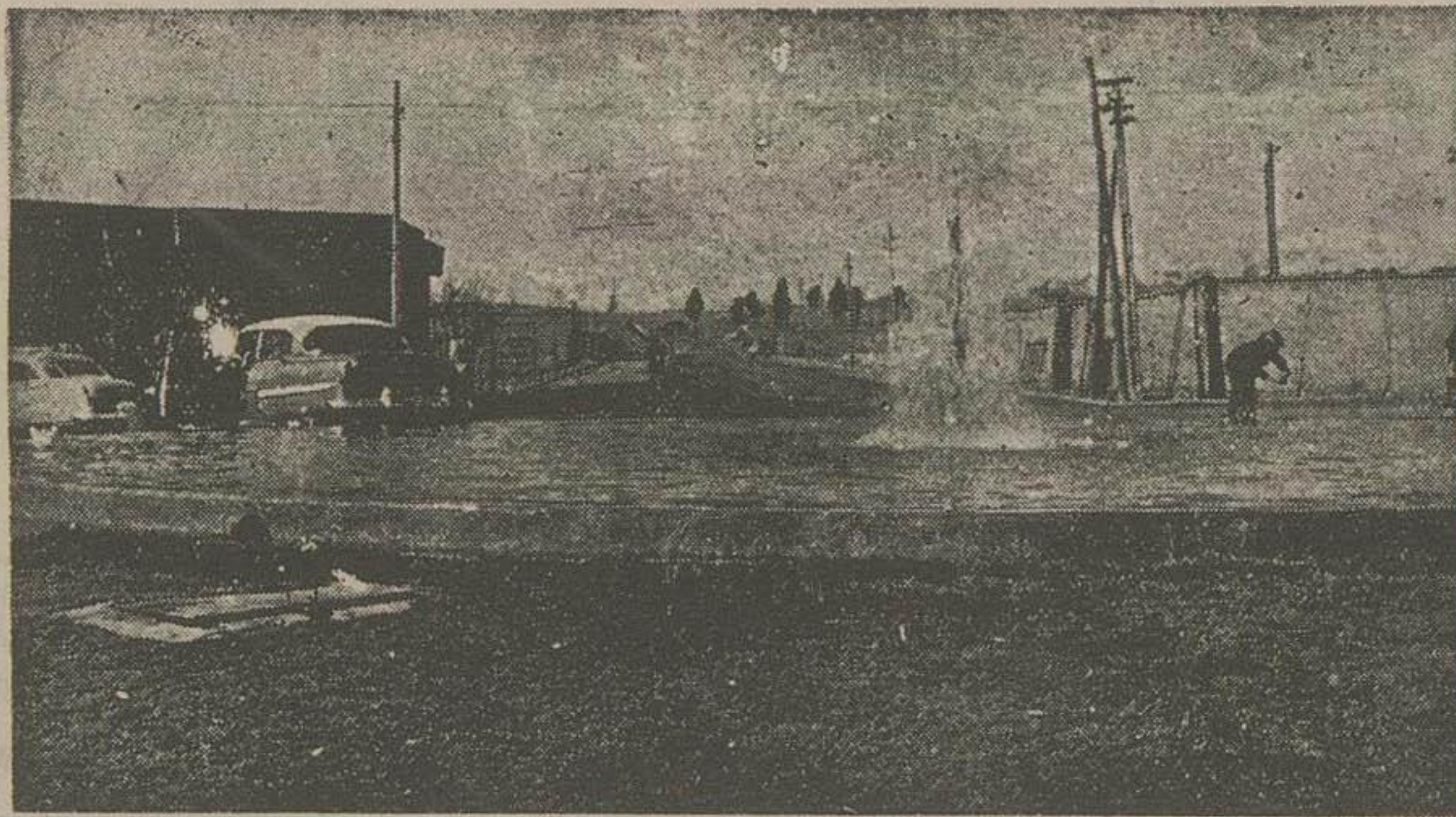
نای میدان داودیه که هنگام غروب منظره ای زیبا دارد و ساختمان پرورشگاه در جنوب آن واقع شده است
