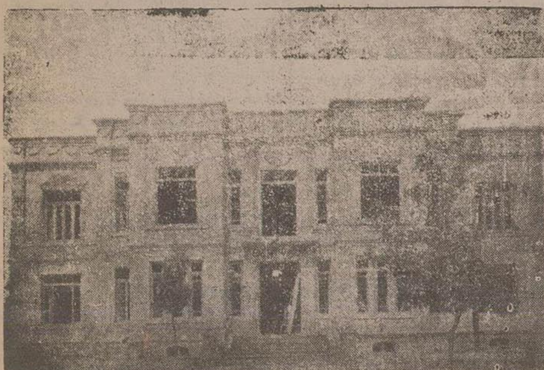
نمای خارجی عمارت اداره شهرتانی ساری که ساختمان آن اخیراً پایان
