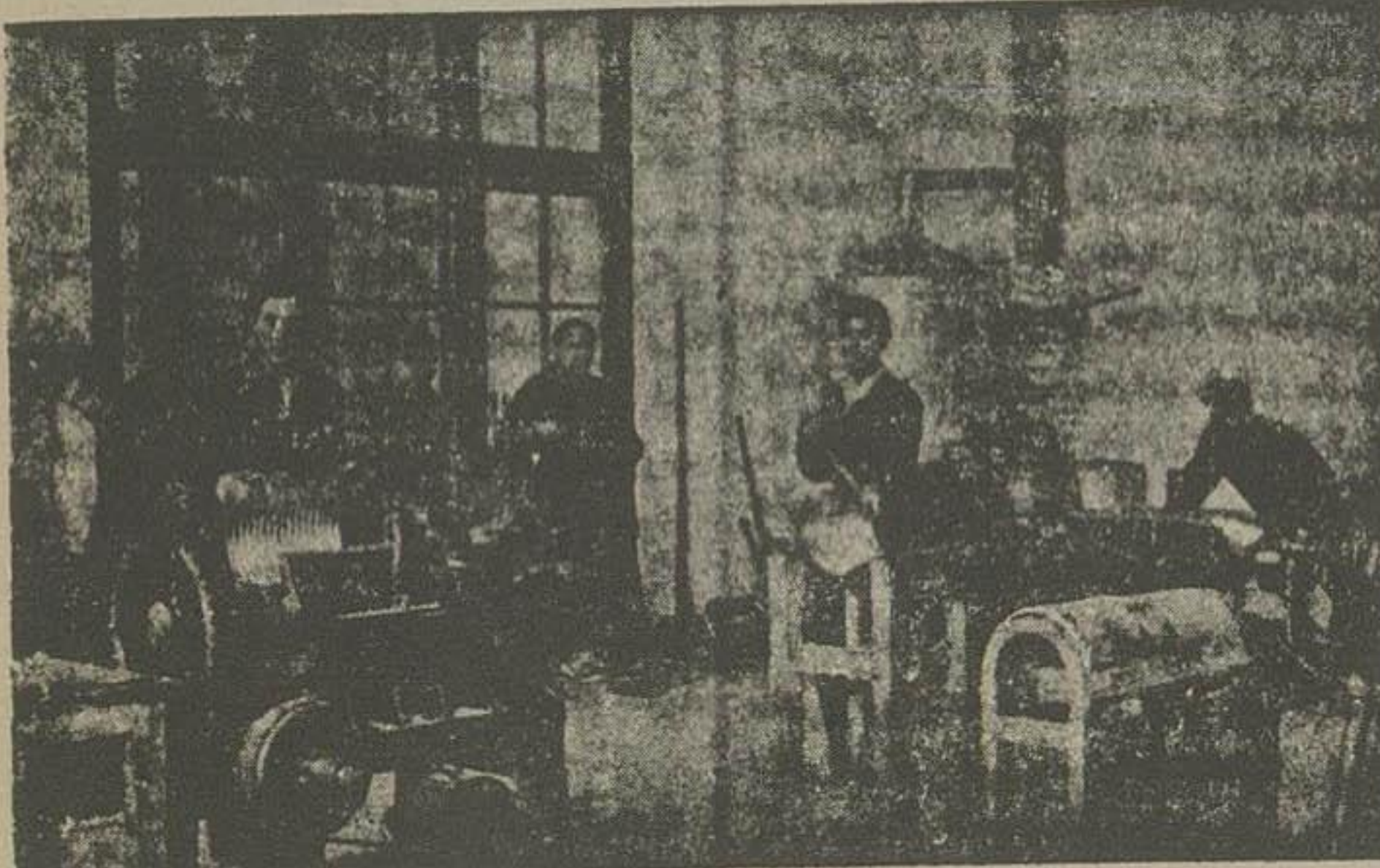
صفحات روزنامه در این قسمت عکس برداری و بصورت فلز در آمده و برای نصب زیر ماشین رتاتیو تدارک میشود
